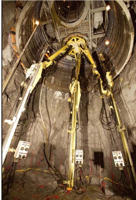
Thi công giếng đứng bằng phương pháp khoan-nổ mìn truyền thống
